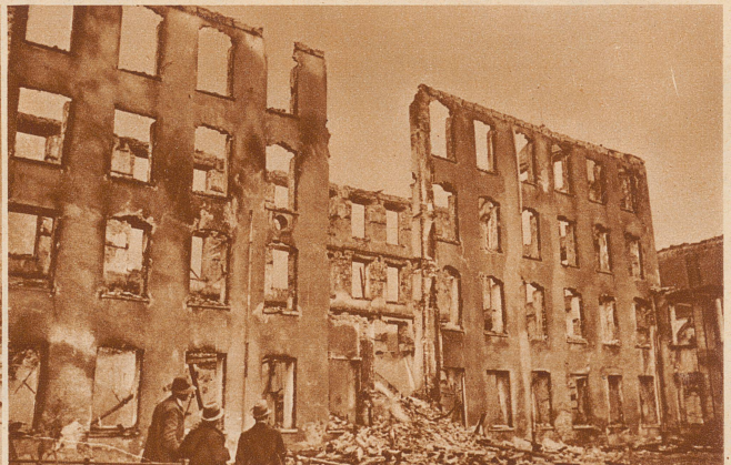
Großfeuer in Schwanden. In der Nacht vom 12. zum 13. Mai ist der größte Teil der ehemaligen Druckfabrik Wyden zwischen Schwanden und Nidfurn, die jetzt in eine Zwirnerei umgebaut, aber noch nicht im Betrieb genommen worden war, von einer Feuersbrunst zerstört worden. – Das total ausgebrannte Hauptgebäude Aufnahme Schönwetter
