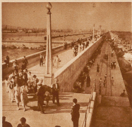
Eine drei Kilometer lange Betonmauer führt längs den Wellenbrechern hinaus ins Meer. Sie ist besonders um die Wägenstraße die beliebteste Promenade von Barcelona.
