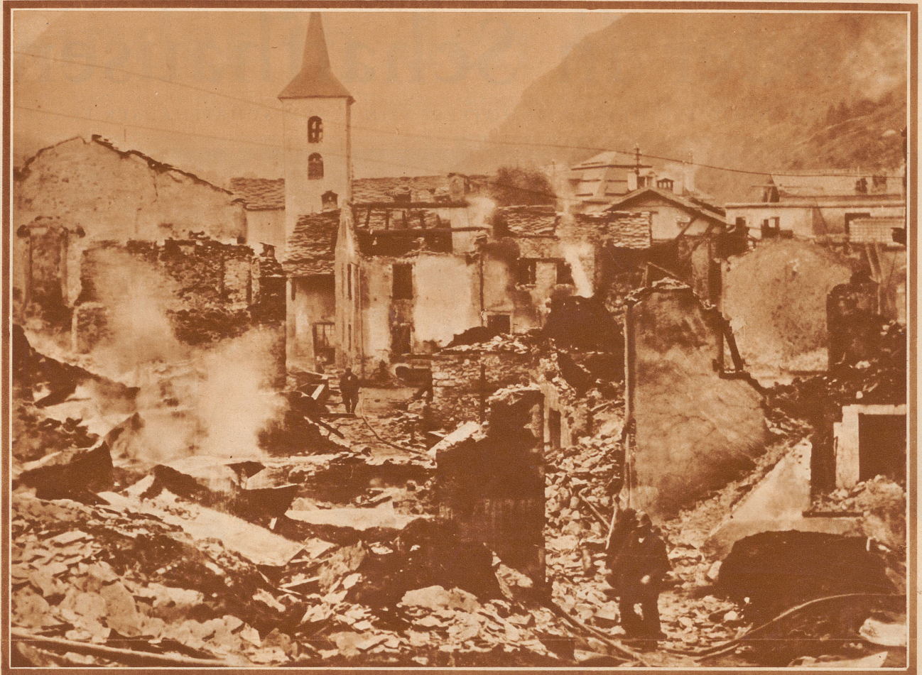
Der neue aus Stein gebaute Dörfteil im Hintergrund blieb mitsamt der Kirche vom Feuer verschont
