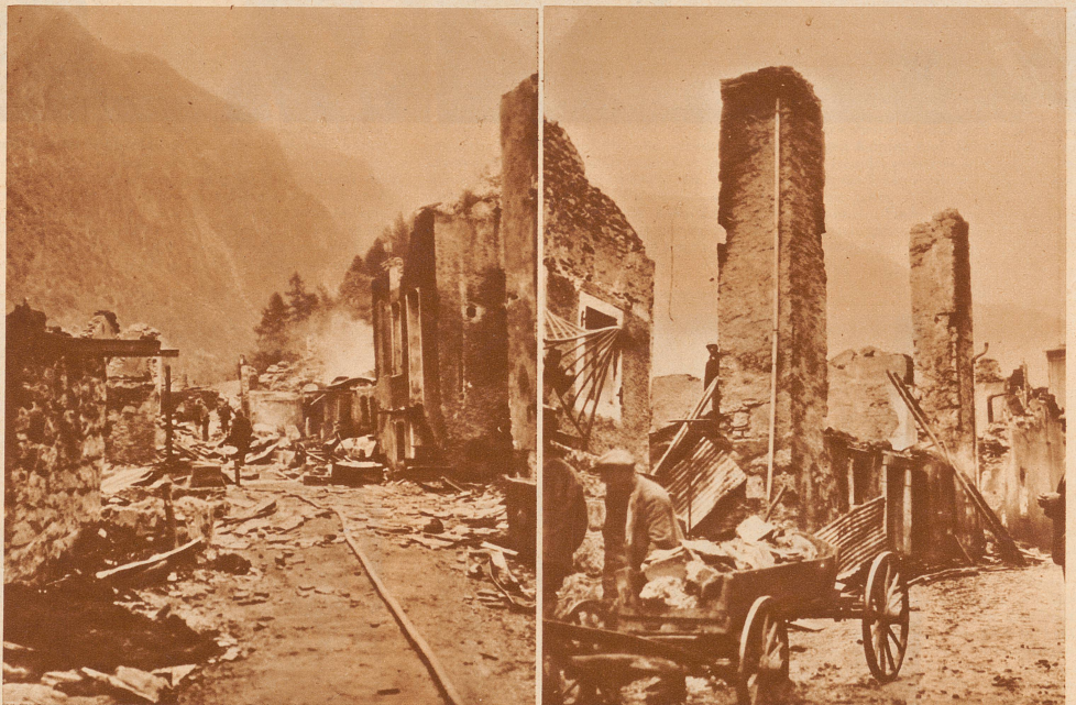
Der Brand beschränkte sich auf den alten Dörfteil, der größtenteils aus Holzbauten bestand, die sich nah aneinander reiheten
