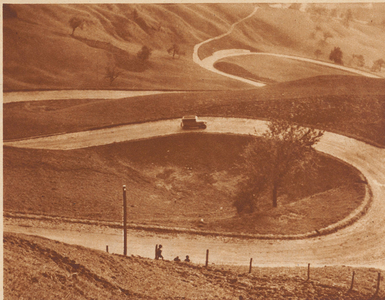
Die neue Pafwangstrafe dem Verkehr übergeben. Nachdem dieser Jura-Uebergang bei den Herbstmanövern eines Teils der 4. Division seine Feuerprobe bestanden und sich in jeder Beziehung bewährt hat, wurde in diesen Tagen die Straße dem Verkehr übergeben. Bild: Die kurvenreiche nördliche Zufahrt zum 175 Meter langen «Zingelen»-Tunnel. Aufnahme Leemann
