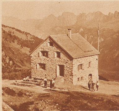
Skihütte «Gaffia» am Piz Sol. Dieses neueste Unterkunftshaus im idealen Skigebiet des Piz Sol steht auf 1780 Meter Höhe. Es ist ein massiver Natursteinbau, der sich ausgezeichnet der Umgebung anpaßt. Die Baukosten belaufen sich auf rund 50 000 Franken. Die Hütte ist in 3¼ Stunden von Wangs aus erreichbar. Aufnahme Fetzer
