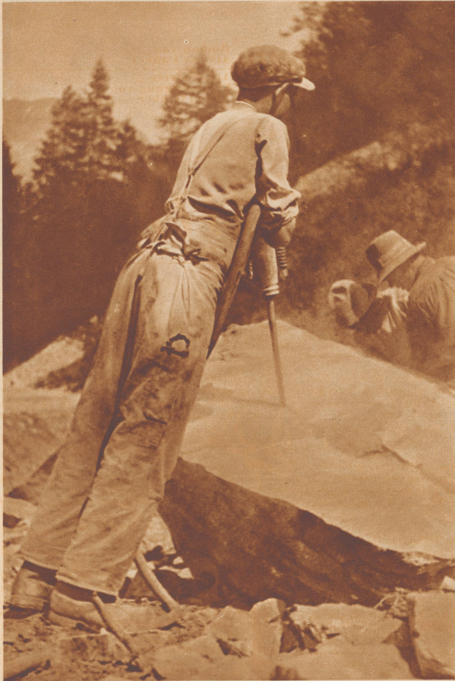
Arbeiter im Puschlaver Marmorbruch mit dem Bohrhämmer, beim Anbohren eines kleinen Blocks.
