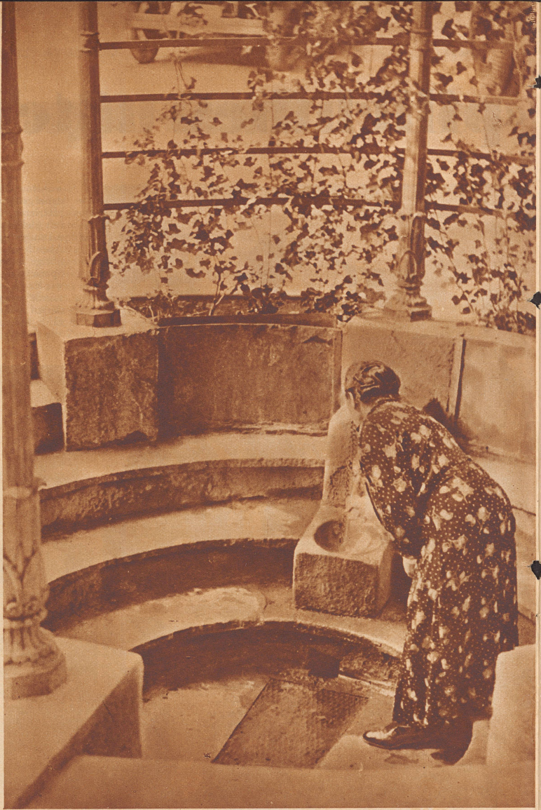
Das «Schwefelbrünnel» in Baden, eine öffentliche Quelle, an der jedermann im Vorübergehen einen Schluck des heilkräftigen Schwefelwassers trinken kann.
