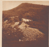
Der Stollen von Cava Tre Fontane am Monte San Giorgio, wo die bituminösen Schiefer bergmännisch abgebaut werden.
