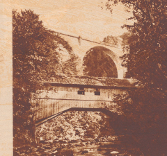
Wie ein Symbol vom Wandel der Zeiten sind diese zwei Brücken über die Lora: Die alte Felsbrücke schief und gebügel, der Beton-Viadukt köhn und elegant.
