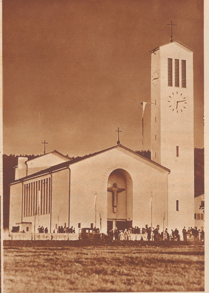
Die neue katholische Herz-Jesu-Kirche in Winterthur. Architekt: Kaczorowski. Die Plastik über dem Eingang ist eine Arbeit des Bildhauers Ed. Bick.
