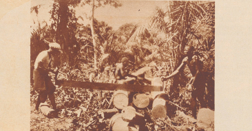
Der an Dr. Schweizers Stellung angrenzende Urwald muß vor der sich ständig ausdehnenden Sozialanlage weichen, und so können die Rodungsarbeiten nie aufhören.
