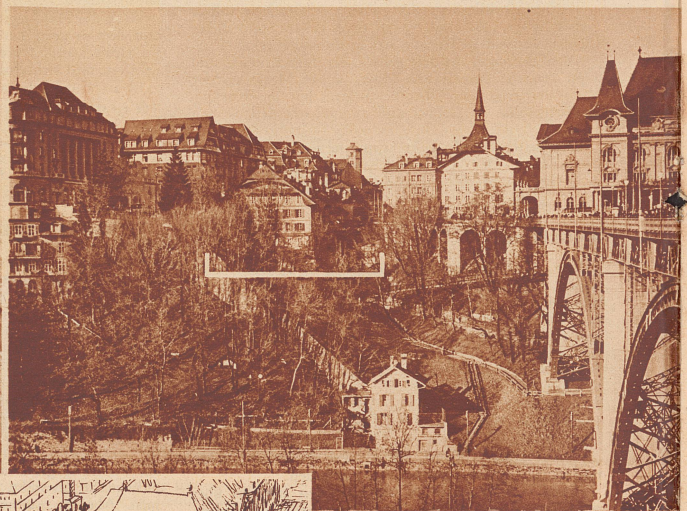
Blick von Süden auf den heutigen Gerberngraben. Links das Bellevue-Palace-Hotel, rechts das Kasino. In der Mitte die alten Bauten, die der Umgestaltung weichen müssen. Auf den 1. Mai müssen die Häuser geräumt werden, dann beginnt der Abbruch.
