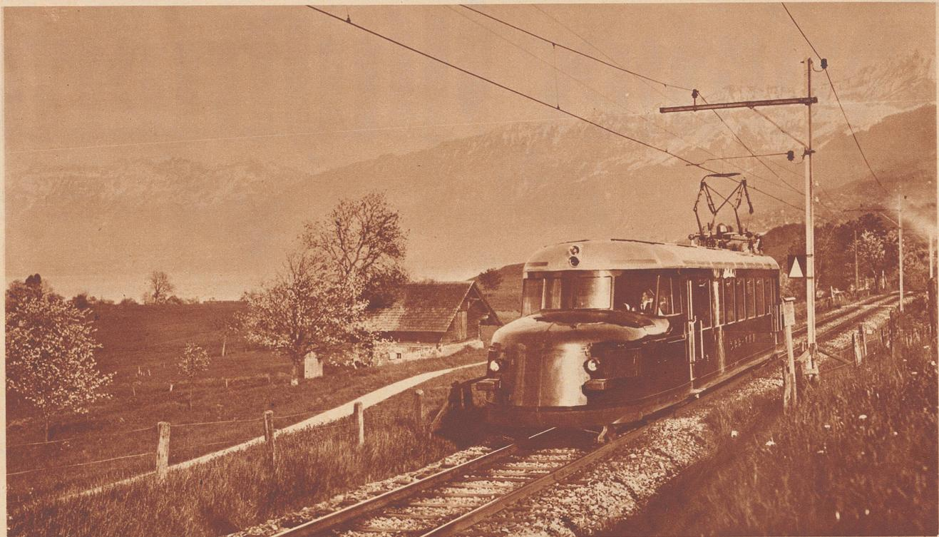
**140 Stundenkilometer bei der SBB.** Der Leichttriebwagen der SBB, mit dem gegenwärtig auf verschiedenen Strecken der Schweiz Versuchsfahrten ausgeführt werden. Der vierachsige Wagen hat 70 Sitz- und 30
