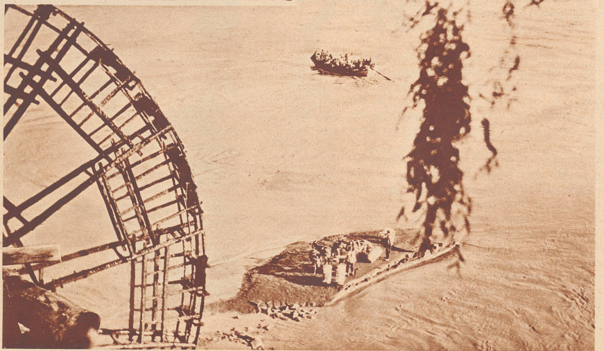
Wasserschöpfrad am Oberlauf des Hwang-Ho. Mit solchen kunstvoll gebauten Holzrädern von über 10 m Durchmesser wird das Wasser zur Berieselung der Kulturen aus den Flüssen auf die höhergelegenen Terrassen befördert. Seit uralter Zeit vollzieht sich die Bewässerung in vielen Gegenden Chinas immer auf diese primitive Art: mit Menschenkraft wird das Riesenrad angetrieben, in Holzbehältern, die an der Peripherie des Rades angebracht sind, wird das Wasser im Fluß gefaßt, durch Drehung des Rades 10 m in die Höhe transportiert, dort in ein Bassin entleert und durch einen Holzkanal zu den Pflanzungen geleitet.
