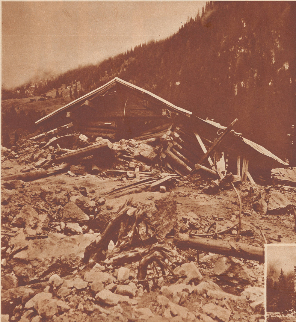
Das Chalet «Alpenrösli» nach der Katastrophe. Das Haus wurde von seinem ursprünglichen Standpunkt um mehrere Meter verschoben. Ganz aus den Fugen geraten, steht es meterhoch im Schlamm und Geschiebe.
