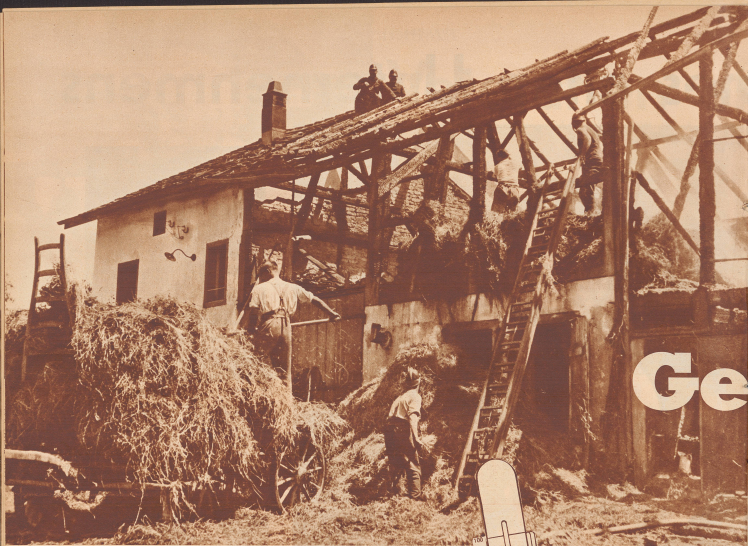
Ein Beispiel von vielen: Der Brandfall durch Selbstentzündung des Heustockes am 8. Juli 1935 in Wetzikon (Zürich). Der Brand im großen ist gelblich. Die Feuerwehr ist daran, den in Brand geratenen Heustock vordringlich mit Wasser zu löschen. Die Feuerwehr hat die Aufgabe, den Heustock zu löschen, um die Brandursache festzustellen. Das vom Stock herabgeworfene Heu ist natürlich ganz durchnässt. Es wird auf Wagen fortgeführt und in dem ungelöschten Wasser zum Trocknen ausgebreitet. Es ist nur noch als Stroh verwertbar.
