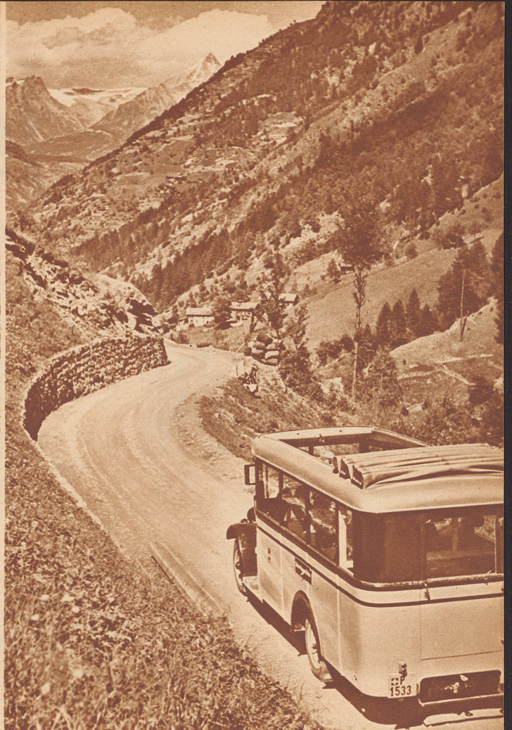
Ein Stück der Straße nach Saas-Fee ist bereits dem Verkehr übergeben worden. Postautos fahren seit einiger Zeit von Stalden gegen Saas-Fee. Bild: Ein Straßenteil in der Nähe von Huteggen, im Hintergrund das Bietschhorn.
