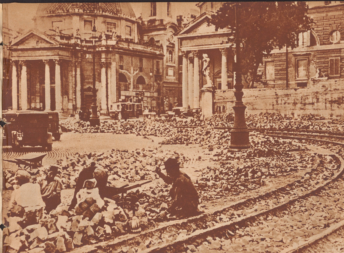
In Rom werden die Straßbahnschienen der Linien, die bereits seit einiger Zeit durch Autobusse ersetzt sind, jetzt herausgerissen, um eingeschmolzen und zu Kriegsmaterial verarbeitet zu werden.
