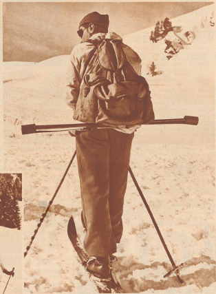
Ein Ausstattungsgerät nur für Gebirgsgruppen und nur für den Winterdienst: die Sondierstange. Sie dient dazu, um im Falle von Verschiebungen durch Lawen sofort die Boden nach Verschiebungen aufnehmen zu können. Die Sondierstange besteht aus mehreren Teilen, die bis zu einer Länge von vier Meter zusammengeschraubt werden können.
