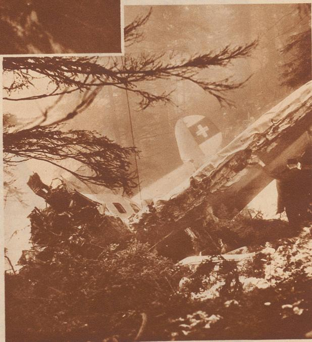
... weitere 30 Meter tiefer lag zwischen vier Tannen eingeklemt die Hauptmasse des Flugzeuges. Der Motor lag abgetrennt unter den übrigen Trümmern, der Pilotensitz war ein einziges Chaos, die linke Tragfläche eingeschlagen. Unter dieser Tragfläche fand man die Leiche des Piloten Gerber, von einem abgebrochenen Tannenwipfel zugedeckt. Der Strich senkrecht durch das Bild ist der Antennendraht, der an den Aesten der Tanne links hängen blieb.
