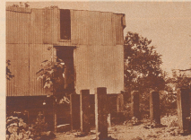
Ein Haus in der Hauptstadt Monrovia, ein Beispiel unter vielen. Die Liberianer besitzen meistens im Großen, was sie später ganz klein vollenden. Im Vordergrund sind die Zementpfiler zu dem stattlichen Hause, das der Grundbesitzer zu bauen vorhersieht. Aber das Geld reichte nicht. Die Pfeiler stehen stumm, hinter ihnen wurde schließlich ein kleiner Weibchenverdrag errichtet.
