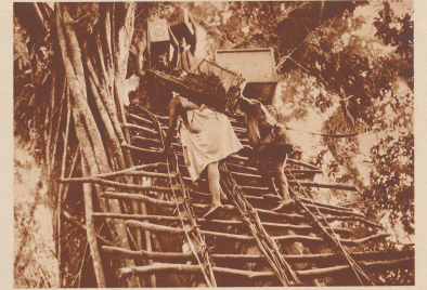
Um sie vor der Überflutung durch die Hochwasser der Regenzeit zu schützen, läßt der Brückenbauer- Urwaldmeister die Hängebrücken fünf Meter über den tiefsten Wasserstand des Flusses schlagen. So die Lössen führen zum Brückenkopf empor, die den schwerbeladenen Trägern viel Schwere können.
