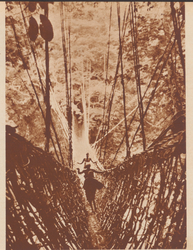
Wie Spinnweben hängt die Brücke, ganz aus Lössen geflochten, zwischen den Urwaldsäulen. Sie scheint leicht geordnet, als gebaut zu sein, so vollkommen ordnet sie sich dem Pläntergeruch des Urwaldes an. Beim Betreten gerät sie in heftigen Schwingungen. Sie ist nur für Schwindelfreie geeignet. Durch die dünnen Matten bläht der Fröhenwind, der darüber geht, auf die Wasser des Flusses hinab und so froh, daß der Urwaldmeister das Geländer rechts hoch heben läßt.
