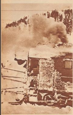
Bei die Lawine nach einem oder mehreren Minenwerfschüssen gesprengt, wobei riesige Schneemassen sich auch auf die Gleise gesammelt haben, so trifft sofort die schneeschleudernde Schneeschleudermaschine auf die Bahn und zieht die Bahn so rasch als möglich wieder frei zu bewegen.
