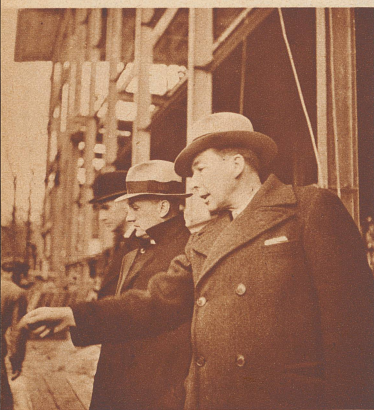
Bundesrat Etter (links) und Dr. Lienert, Direktor der Zentrale für Handelsförderung (rechts), besichtigen den Stand der Arbeiten am Schweizer Pavillon.
