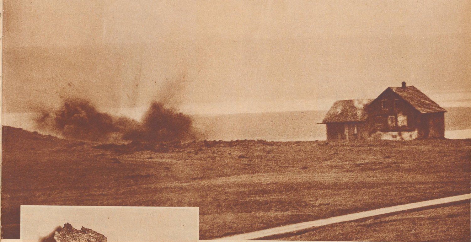
Eine 50 kg-Sprengbombe explodiert bei Momentan- oder Aufschlagzündung 30 m vom Versuchsobjekt entfernt. Die Wirkung war folgende: Luft und Erde erfuhren eine heftige Erschütterung, die auf eine Distanz von über 1 km deutlich wahrnehmbar war. Die Detonation war auf viele Kilometer weit hörbar. Am Gebäude wurden alle Fensterscheiben, die nicht entfernt worden waren, eingedrückt, eine Anzahl Dachziegel heruntergeworfen und die Mauern des Hauses durch Splitter beschädigt.
