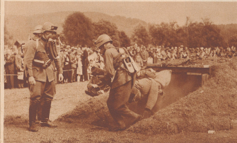
Bei den Vorführungen der verschiedensten neuen Waffen und Ausrichtungen fand die Klärung eines vergrabenen Soffens durch die mit Kerndol-Gräten ausgerüstete Räumungsmannschaft der Minen-Truppe besonders Interesse. Démonstration des troupes de mineurs procédant à l'évacuation d'un abri souterrain.
