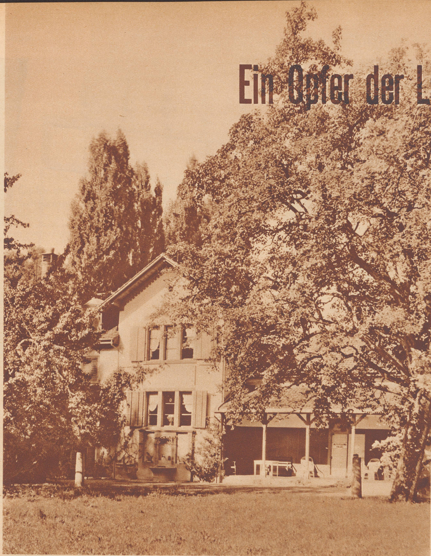
Das Kollergut, wie es heute aussieht. An das Wohnhaus schliessen sich rechts das ehemalige Atelier und die Stallungen an. La propriété Koller dans son état actuel. Cette maison sera démolie pour les besoins de l'Exposition nationale, Zurich 1939.
