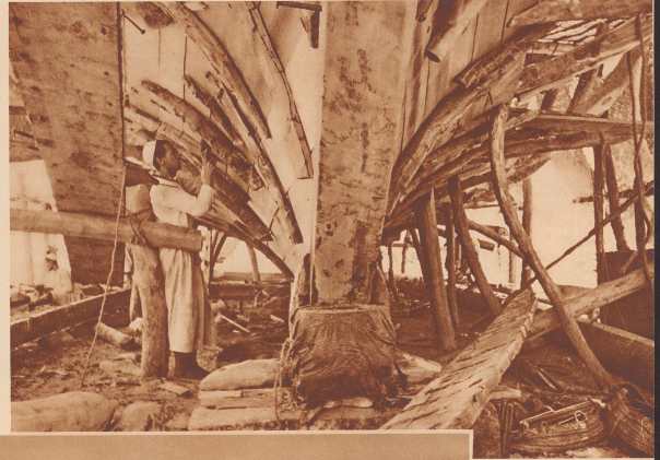
Arabische Boote im neuen Bauzustand. Schon sichtbar ist der Rumpf des Dreihundert-Tonnen-Seglers ab. Die Innenwand des Schiffes wird verschalt. En chantier, voici la coque intérieure d'un bateau de 300 tonnes.
