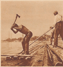
Bei Bamberg unterhalb Bamberg wird das Floß zusammengebaut, eine Arbeit, die mehrere Tage in Anspruch nimmt. 500 Flößerarbeiten werden mittels Öfen, Hebezeug und 18-cm-Nagel verwendet. Die entzerrten Stämme bilden drei Lagen übereinander. Die Kubbolmen ausgeleuchtet sind das 280 er -Floß. A Bamberg, on arrive le train de bois. Opération difficile et qui prend plusieurs jours. Le radeau est constitué par trois couches superposées de troncs qui sont assemblés par des traverses faites par des clous de 18 cm.
