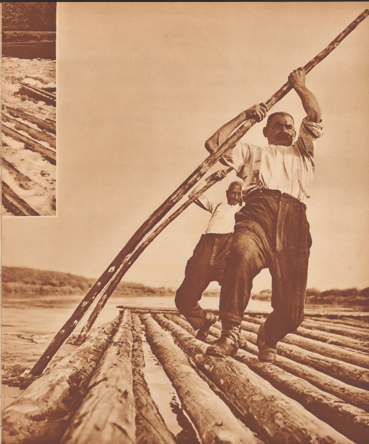
Im Tempo von 10 bis 40 Stundenkilometer schwimmen das Floß den Main hinunter. Mit ihren 6 Meter langen Flößestangen, Stielen genannt, halten zwei Leute das Floß beständig in der Schwebe, während jegliches Schwerkraft über sie vermindert und durch das Floß elegant um die Mauwöhlungen und zwischen den Brückenjochen hindurch. Diese Arbeit, die beträchtlichen Muskelaufwand und große körperliche Gedächlichkeit erfordert, nennt man i. Eöcken. Des artistes habiles. Entre Schwinger et Ochsenhart, le floue coule à une vitesse de 30 à 40 kilomètres-heure. Menés de gaffes de 6 mètres, le compagnon et ses aides dirigent le radeau et le maintiennent dans le courant. Cet exercice exige autant d'adresse que de force.
