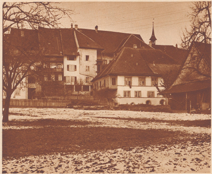
Ein Teil der engen Häuserzeile an der Hauptstraße, von der Rückseite aus gesehen. Rechts das Türmchen der St. Katharinenkapelle. Wiedlisbach ist wohl die einzige Siedlung in der Schweiz, die keine eigene Kirche hat. In der nach Oberbipp hinliegenden, im Vordergrund sieht die alte Mühle von Wiedlisbach, die urkundlich zuerst im Jahre 1368 erwähnt wird.
