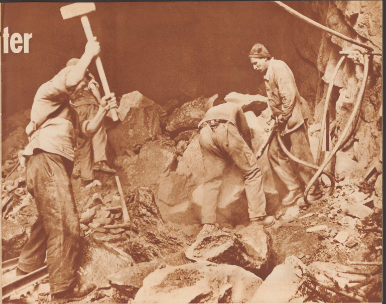
Die Meienreuf der Sustenstrasse Tunneln am Werk. Die Arbeit ist mühsam in dem härtesten Granit. Götthardgranit gehört zum härtesten aller Gesteine. Mit sehr starken Sprengladungen können nur ganz kleine Quantitäten gelöst werden. Le travail est souvent dangereux, il est également pénible. L'humidité souille des murs et le granit de Götthard est l'une des pierres les plus dures qui soient.
