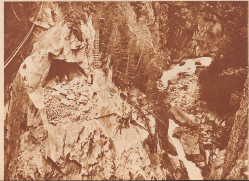
Die Meienreuf der Sustenstrasse Tunneln am Werk. Die Arbeit ist mühsam in dem härtesten Granit. Götthardgranit gehört zum härtesten aller Gesteine. Mit sehr starken Sprengladungen können nur ganz kleine Quantitäten gelöst werden. Le travail est souvent dangereux, il est également pénible. L'humidité souille des murs et le granit de Götthard est l'une des pierres les plus dures qui soient.
