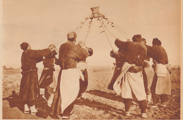
Der «Adernanzubilliger» in Tätigkeit. Ein uraltes Instrument, mit dem der Dammbau «früher» wird. Acht Mann schleudern den ungefähr 40 Kilo schweren Schlager in 3 Meter langen Seilen in die Luft und lassen ihn auf die Erde niederfallen. Rund 2 Millionen Kubikfuß Erde wurden so bei diesem Dammbau nicht der Dampfmaschine, sondern von Hand festgestampft.
