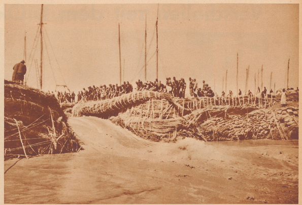
Das Dammbau geht einem Ende entgegen. Eine Lücke von 10-12 Meter Breite ist noch zu schließen. Mit großer Wucht schließt das Wasser durch die Öffnung; darum ist diese Endphase der schwierige Stück Arbeit. Eben wird eine der letzten mächtigen Fäden als sogenanntes Sakutik ins Wasser gelassen. Diese Fäden sind hergestellt aus 12-15 Meter langen Weiden, ausgefüllt mit Erde und Kien und zusammengehalten mit dicken, auf dem Platze hergestellten Stricken. Zehntausende von toden Fädenwurden wurden bei diesem Dammbau zum Schutze des Lehmkerens benötigt.
