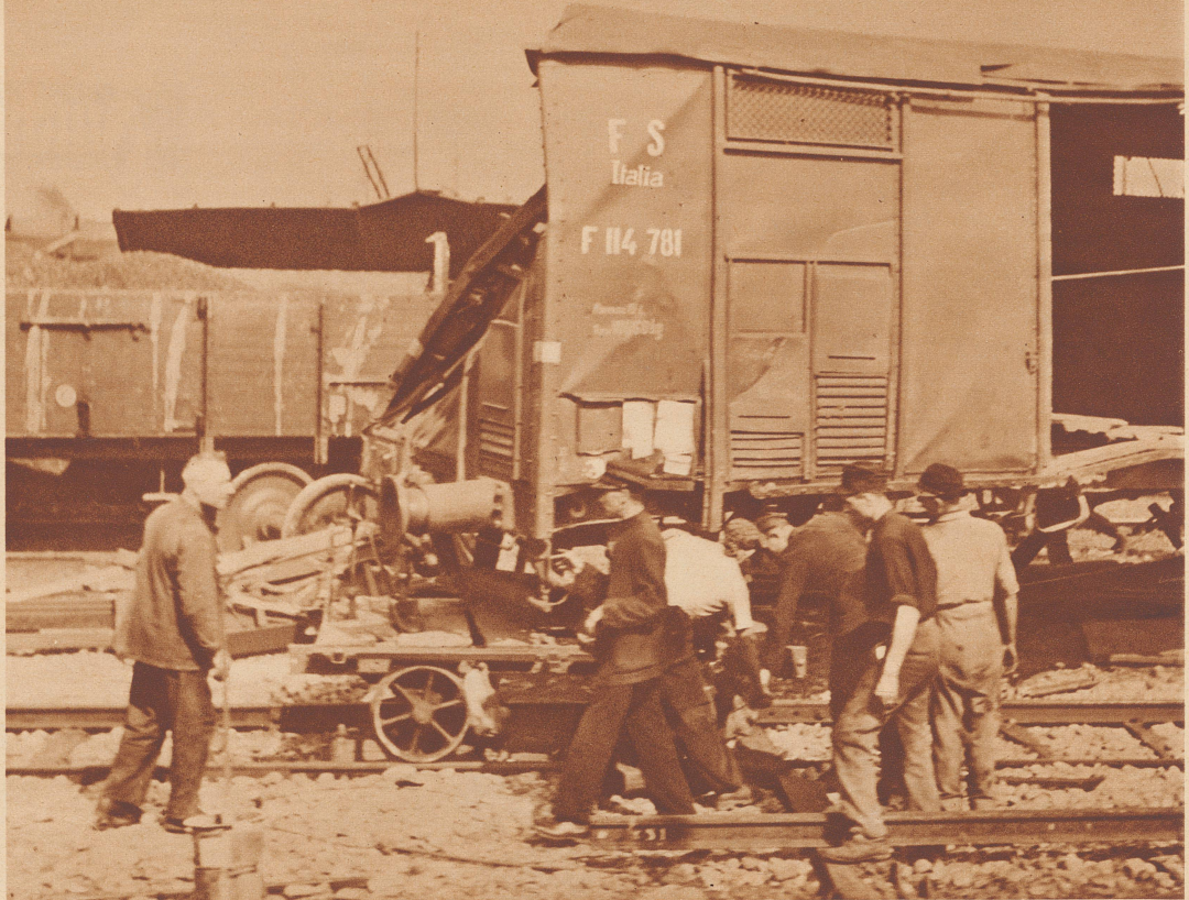
Aufräumungsarbeiten nach der Katastrophe. Der Zug war aus 57 Wagen zusammengestellt. 25 Wagen wurden radikal zertrümmert, 25 andere — wie derjenige auf dem Bilde — wurden stark beschädigt. Vom ganzen Zug blieben nur 7 Wagen intakt.
