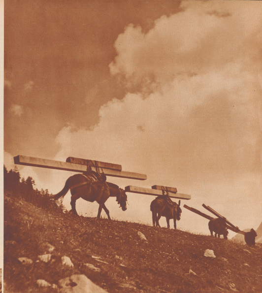
Das Maultier im Dienste des Bergwerkes. Schwer beladen mit 2-7 Meter langen Balken, die für den Bau einer Verankerung auf der Kapp-Alp hinter Ernen im Goms bestimmt sind, marschieren die Kolonnen durch Rappent. Jede Maultier trägt eine Last von 120-150 Kilogramm.
