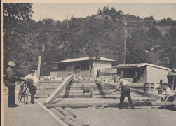
Grenzbekimpere mittels Holzbohlen und Steinblöcken. A la frontière, on ferme les ponts au moyen de poutres en bois et de blocs de pierre.
