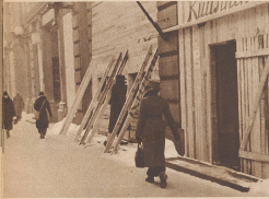
Eisplandegaten, die Hauptgeschäftsstraße von Helsinki. Um die Schaufenster und Anlagen von Fliegerbombenplättchen zu schützen, sind die meisten Häuserfronten in einem Bretterverhagel gekleidet.
