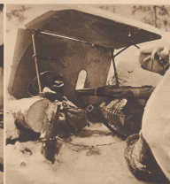
Schutzschild aus Stahlplatten, das die finnische Infanterie für feste Stellungen verwendet. Der fröhlichere Schnee hat die Gefreite gut getarnt gegen Sicht von vorn und von oben.
