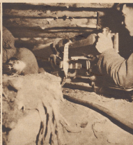
Schwere Maschinengewehr in eingebauter Stellung. Das ganze Dvorn und Dvorn entfernt an seine Betriebsstellen, wo der Bergmann mit dem Pfeilhubbohrer bei der Arbeit liegt.
