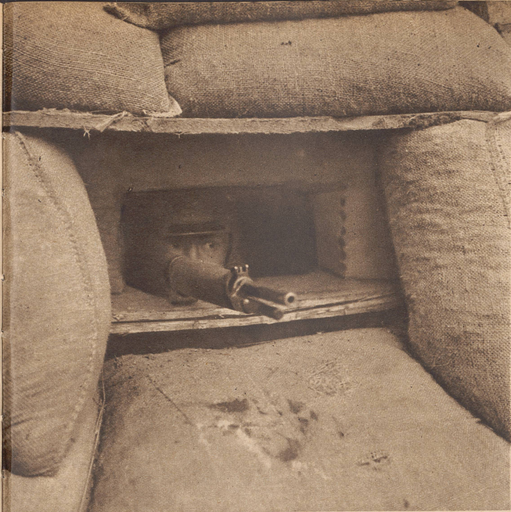
Im Keller eines Hauses am Rande des Dorfes installierter Posten mit Blick übers offene Vorfeld zu den feindlichen Vorposten. Gegen Bombensplitterwirkung ist der Ausguck durch Sand- und Holzwollensäcke geschützt.
