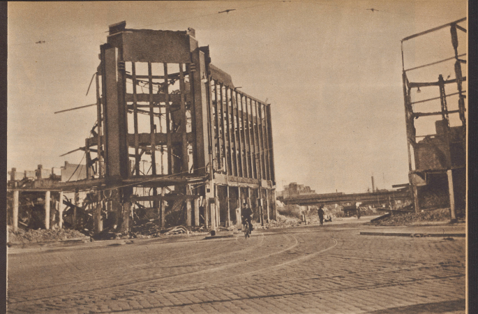
19 Meiner ist eine Durchbruchstraße durch den alten Stadtteil, die erst vor einigen Jahren angelegt wurde. Viele alte Häuser wurden dabei zerstört, aber die neuen Neubauten haben heute noch große Massen. Links und rechts der Wuppertalbrücke. Le Meiner, grande rue commerciale et piétonnière de grands magasins.
