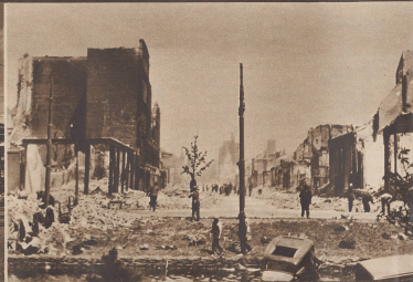
7 Art van Nieuwstraat. Einstehe Läden, Metzgerei, kleine Gewerkschaftsbüro wohnen hier und in der nächsten Straße, machen zu den in schritten vollständig zerstört Rotterdam gelassen. Art van Nieuwstraat. Sur des quartiers les plus pauvres de Rotterdam, quartier du redoublent principalement des artisans et de petits employés.
