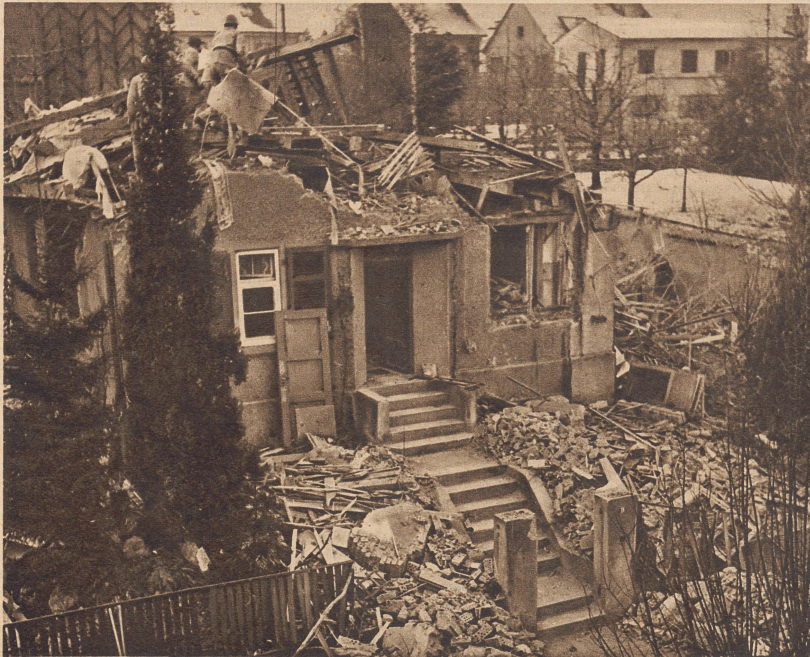
Hier gab es drei Todesopfer. Es ist das Haus am Höhenweg in Binningen, das von der Familie Zeller-Bolz bewohnt war. Die Bombe fiel mitten aufs Dach. Vom einstürzenden Gebälk wurden die Großmutter, die Mutter und eine Tochter getötet.
