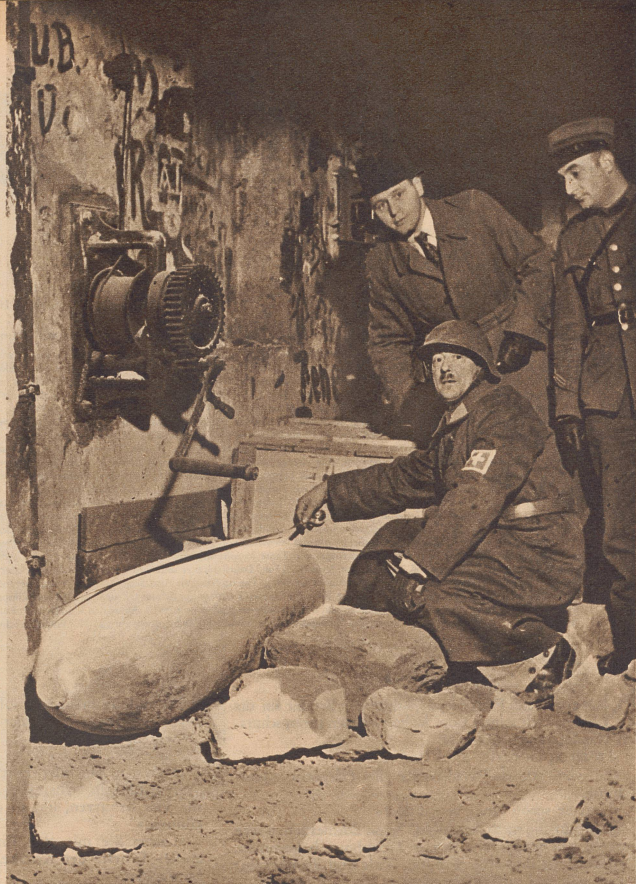
Ein Blindgänger. Er fiel neben das Haus Güterstraße 167, durchschlug das Fundament, drang von der Seite in den Keller ein und blieb dort liegen. Die Bombe ist 1,30 Meter lang, hat einen Durchmesser von 55 cm und wiegt 500 Kilogramm.
