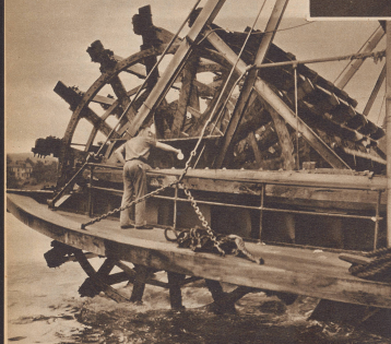
Ursen: Vor der Anfuhr an dem Hafen wird das ganze Schiff geprüft und gadmastet. Am meisten Sorgfalt wird dabei auf das große Hochdruckventil verwandt, das die Bewegung des Vaters des Bootes steuert. En bas: Avant chaque départ, le bateau est l'objet d'une minutieuse révision. La roue à aubes, cœur du bâtiment, est naturellement l'objet des soins particuliers.
